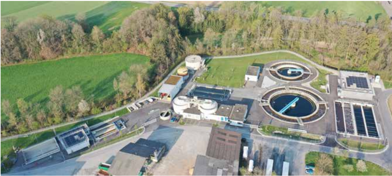
Gesamtansicht der 50-jährigen Anlage.
